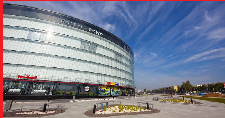
Galeria Echo, Kielce – rozbudowa
